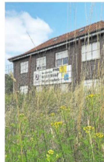
Auf dem Gelände des Falkenhofes, einer früheren Gaststätte, sollte das Hospiz entstehen. Foto: Archiv
